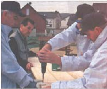
Im Diablotreff in Froberg setzen die WEG-Mitarbeiter fleische Akzente im Lebensgarten. Sie errichteten Holzverschaltungen für neue Hochbeete, die später befüllt wurden. Foto: privat
