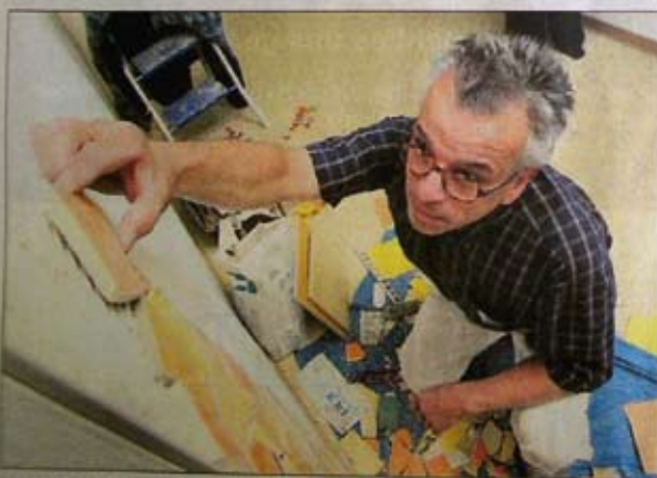
Fliesenleger Rainer Bauer arbeitet an einem Torbogen.
