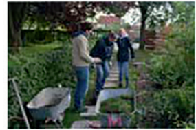
Verlegen von Gehwegplatten ASSMANN Beraten und Planen GmbH und Remenhof gGmbH
